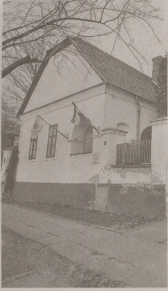
A Végh-kúriát is felújítják
